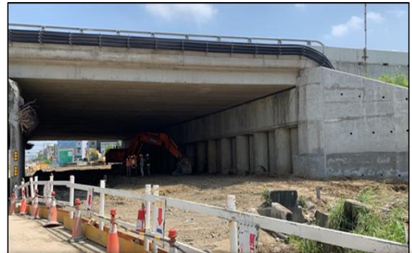
特27既有車行箱涵拆除施作
