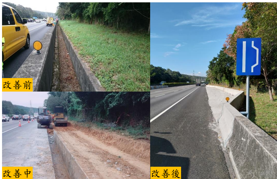
圖 7 國道 1 號南向楊梅至湖口增設避車彎改善前後對照圖
