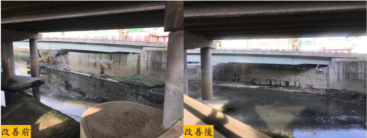
圖 7 國道 1 號臺南交流道北上匝道橋東側銜接段防洪牆工程改善前後對照圖
