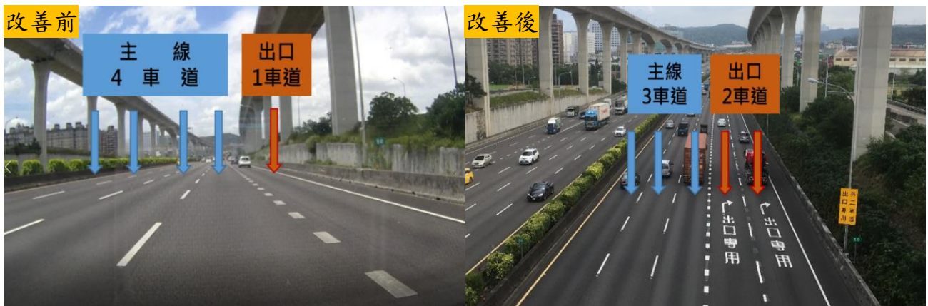
圖 5 國道 1 號北向機場系統至桃園路段改善前後對照圖
