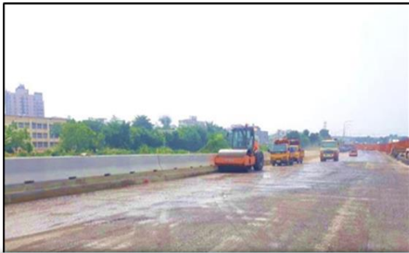
路堤抬高段級配底層鋪築
