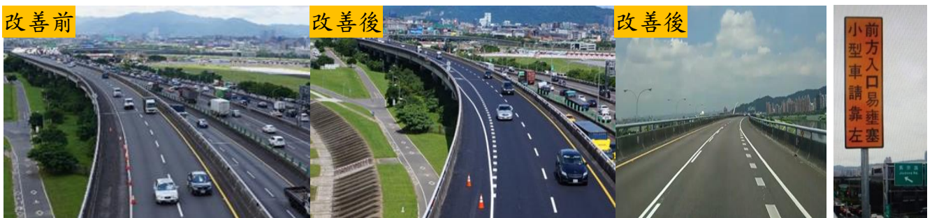
圖 7 國道 1 號高架堤頂南向入口改善前後對照圖
