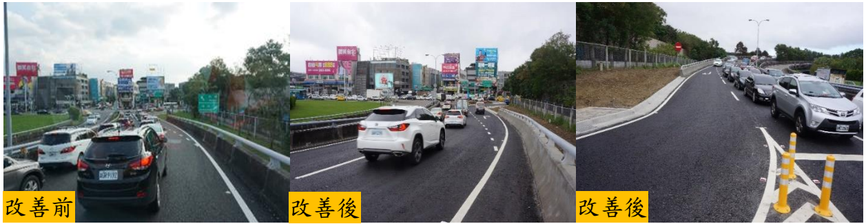
圖 8 國道 1 號高架堤頂北向出口匝道改善前後對照圖
