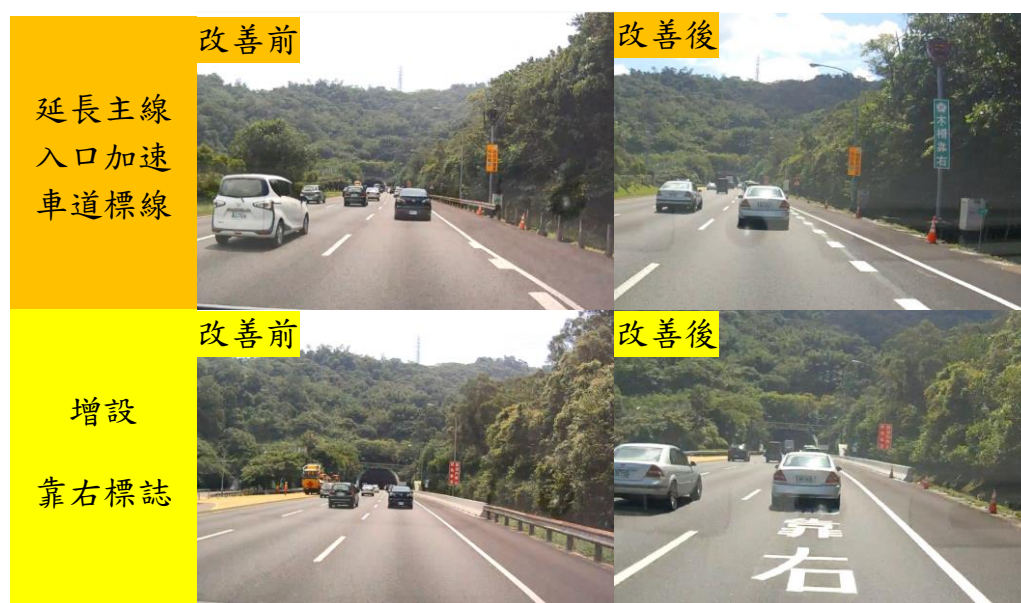
圖 15 國道 3 號木柵休息站-木柵交流道標線標誌改善前後對照圖
