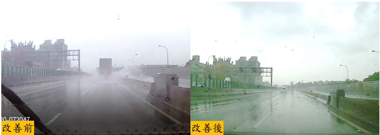
圖 15 國道 1 號 371k+600~373k+000 排水設施改善前後對照圖
